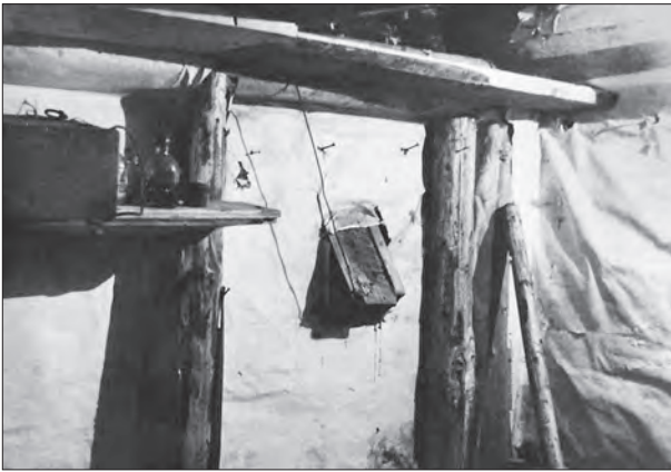
48 pav. Viduje popieriumi išmuštas bunkeris. Matomos konstrukcijos detalės: vertikalūs statramsčiai, lubų sija, vėdinimo anga ir interjero detalės: lentyna, į sieną įkaltos vinyz rūbams pakabinti (GAM, GEK7777, PF2065-25).
